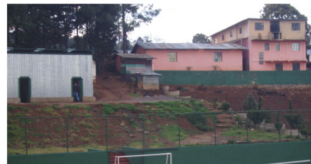
Werkstatt • altes Schulgebäude • Ergänzungsbau
